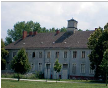
Das Haus 1 auf dem FH-Campus wird derzeit saniert. Foto: bic
